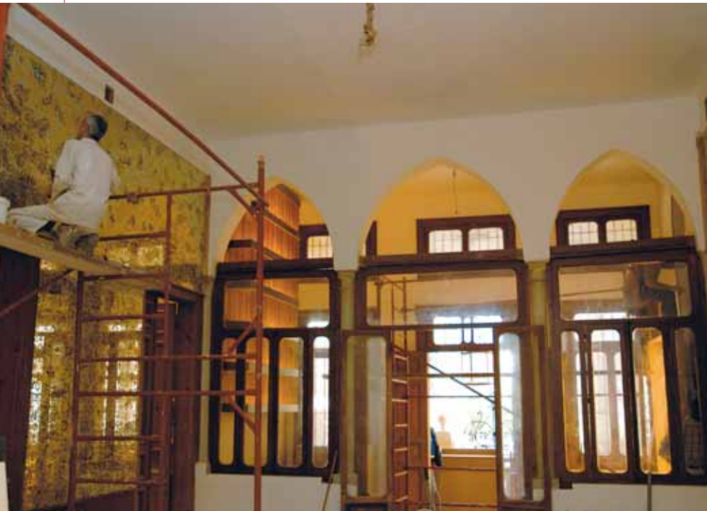
Al-Mijana en travaux. La nouvelle carte intégrera de la cuisine marocaine et iranienne.
